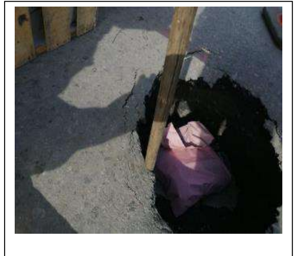
Colector colapsado, azolvado y con raíces de árboles. Se observan pedazos de tubería de concreto en parte superior, en parte inferior ya no existe tubería Calle: Guadalupe Victoria: Georreferencia: 16.33706557.-
