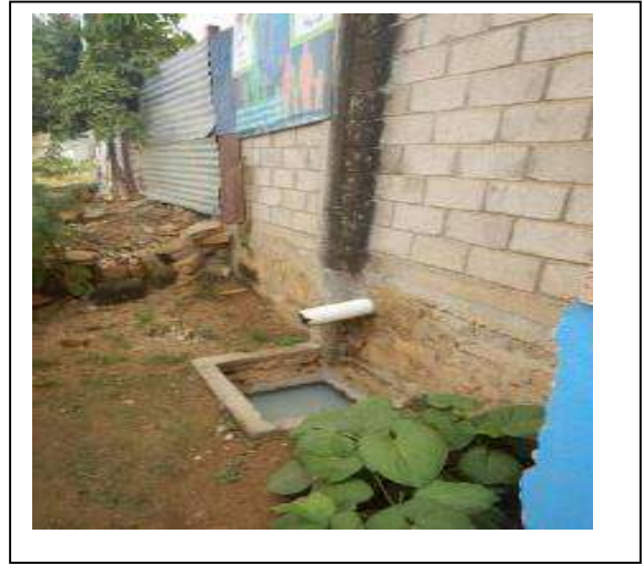
Se observa descarga de residual sobre la calle Colon. Georreferencia: 16.33386576,-95.229138.
