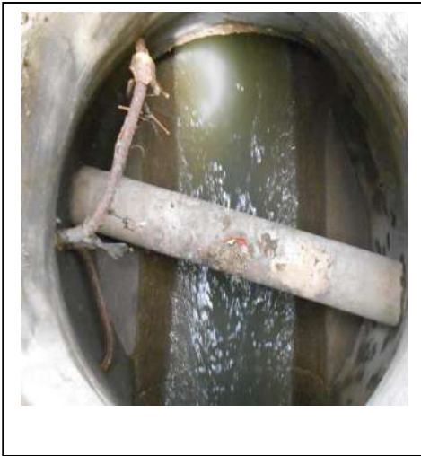
Tubería de la red de agua potable atravesando la tubería del drenaje sanitario, también se ve el traspaso de raíces de árboles. Calle Cuauhtémoc: Georreferencia: 16.345996228,-95.22048908
