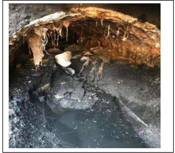
Colector colapsado, azolvado y con raíces de árboles. Se observan pedazos de tubería de concreto en parte superior, en parte inferior ya no existe tubería Calle: Guadalupe Victoria: Georreferencia: 16.33706557.-
